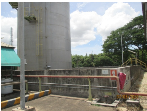
รูปที่ 3.2-41 คันคอนกรีตรอบพื้นที่เก็บสารเคมี
