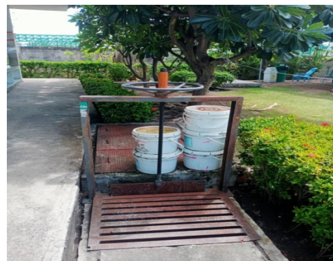
รูปที่ 3.1-4 ประตูเปิด-ปิด และกั้นทรายกันบริเวณวางระบายน้ำฝน
