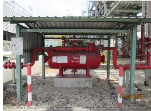
รูปที่ 3.2-32 ระบบโฟมดับเพลิง
